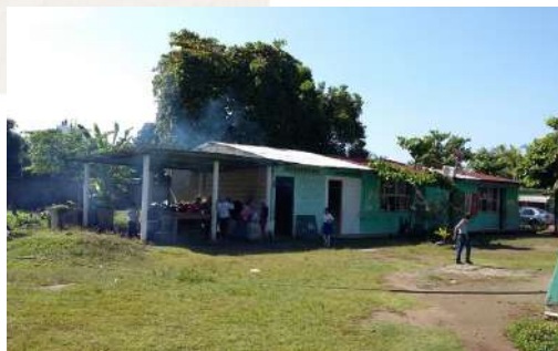
Imagen 55. Cocina sin instalaciones
