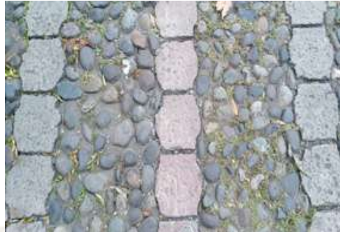
Imagen 126. Detalle: Adoquín y piedra bola
