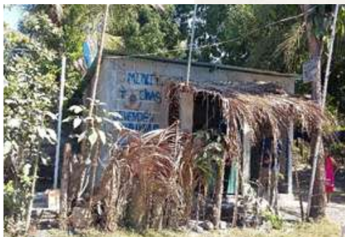
Imagen 9. Vivienda. Bloque hueco y lámina
