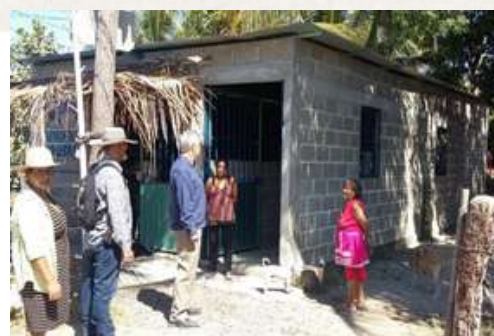
Imagen 6. Vivienda. Bloques y lámina
