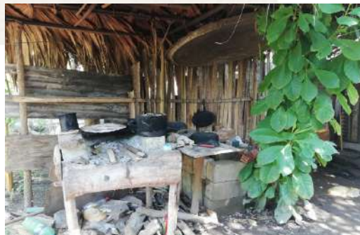
Imagen 34. Fogón sobre base de tabique
