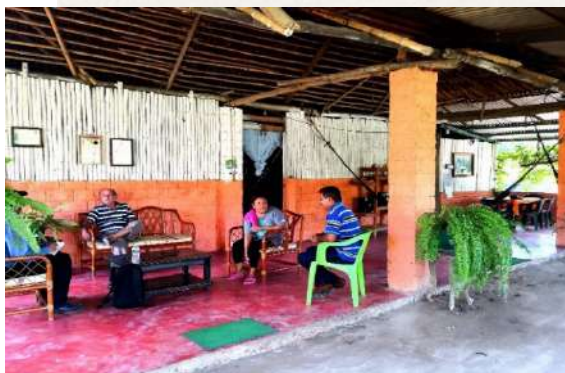
Imagen 61. Vivienda de origen vernáculo, con mezcla de materiales tradicionales e industriales.
