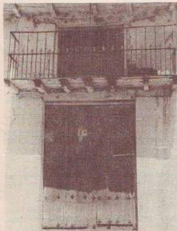
Portada con balcón de hierro forjado. Siglo XVI; encontrábase en la plaza principal (demolido hace pocos años). Chiapa de Corzo, México.
