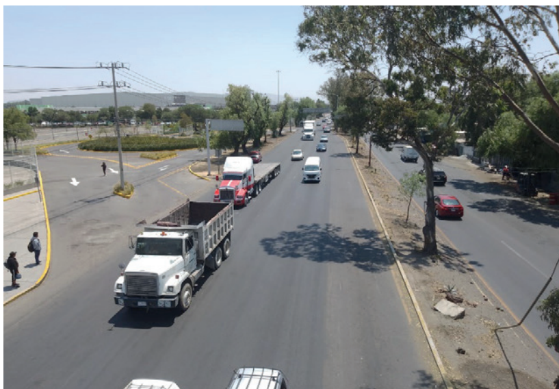
Figura 8.3. Vialidad con nivel de servicio tipo c
