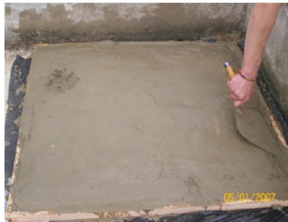
**Figura 7.** Extendido de mortero
