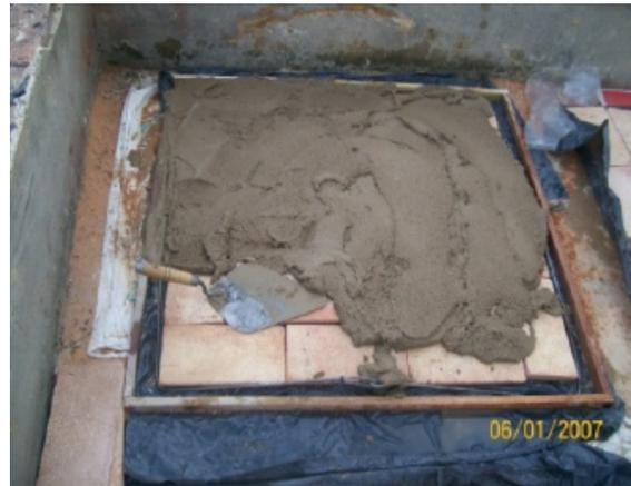
**Figura 6.** Aplicación de mortero
