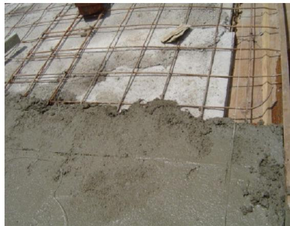
**Figura 17.** Placa rigidizante de concreto
